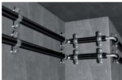
Крепление стальных трубопроводов в защитной оболочке
